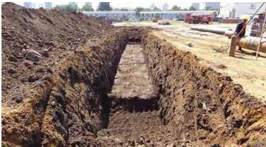
图 8.3 沟槽土方开挖
