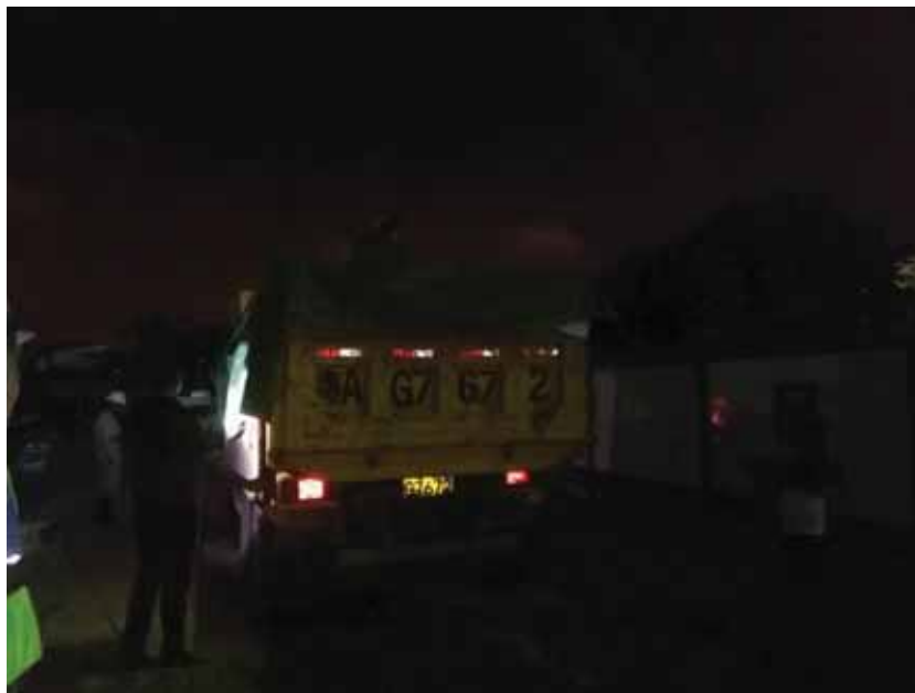
图 8.23 运输车辆覆盖、冲洗情况检查
