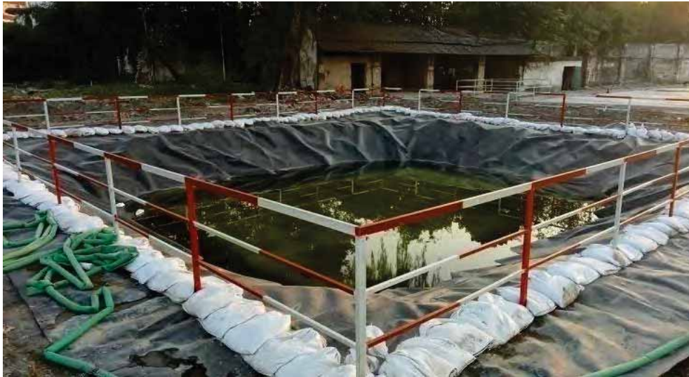
图 7.17 调节池铺设 HDPE 膜
