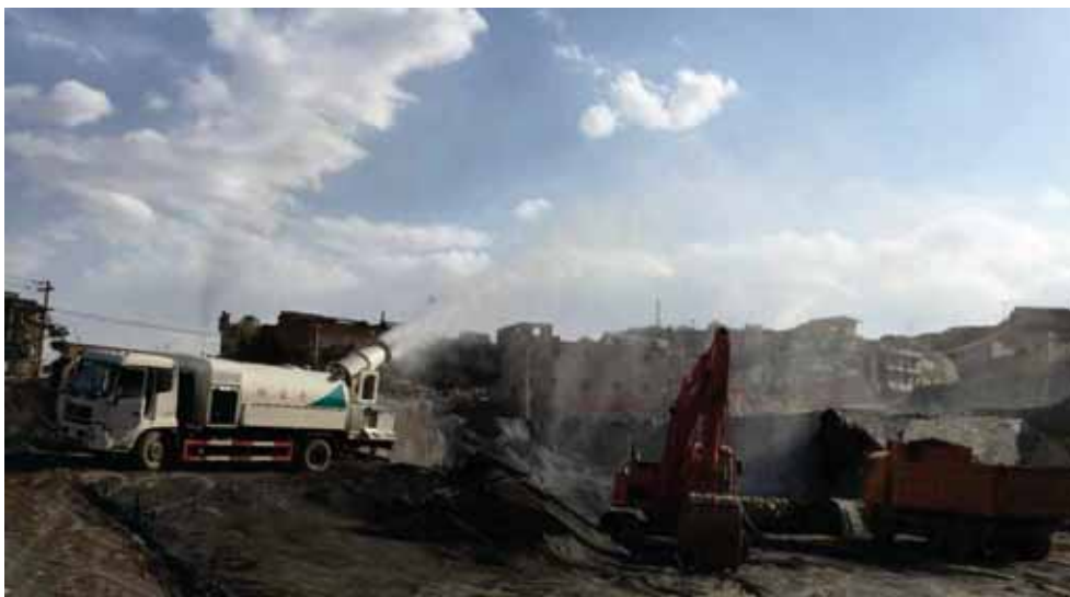
图 7.14 多功能抑尘车喷雾降尘
