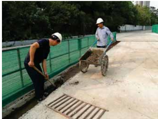
图 6.21 污染渣土冲洗场污泥清理
