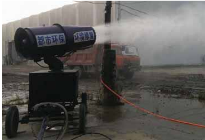
图 7.10 作业面雾炮降尘
