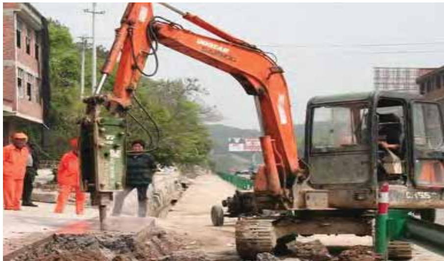
图 8.15 液压破碎锤地坪破碎
