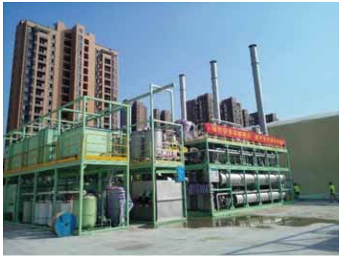
图 7.19 污染土壤间接热脱附修复系统有组织排放监测点(P2)
