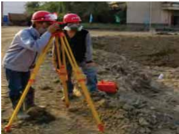
图 8.17 测量放线工程监理旁站
