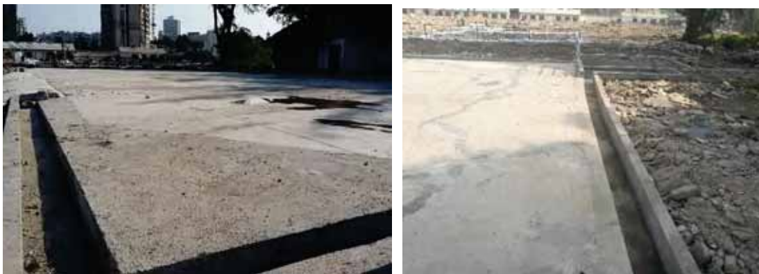
图 6.26 污染渣土冲洗场外围排水沟和沉砂池
