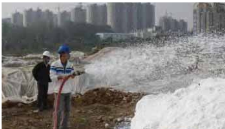
图 7.9 作业面喷洒气味抑制剂
