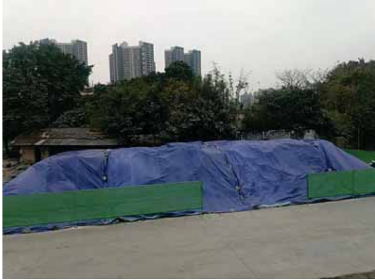
图 6.20 冲洗后渣土的堆置
