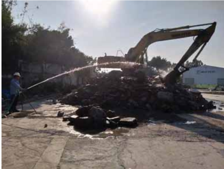
图 6.18 污染渣土冲洗
