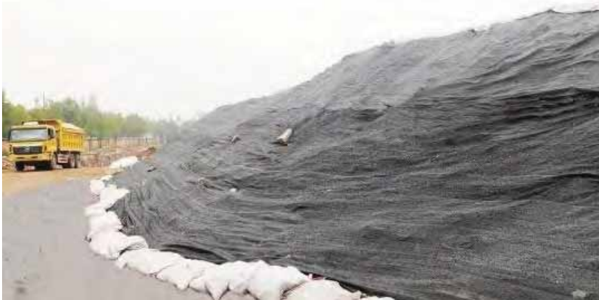
图 7.8 污染渣土覆盖
