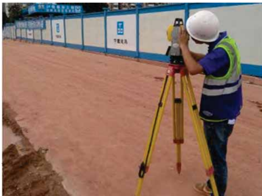
图 8.11 场地高程测量示意图
