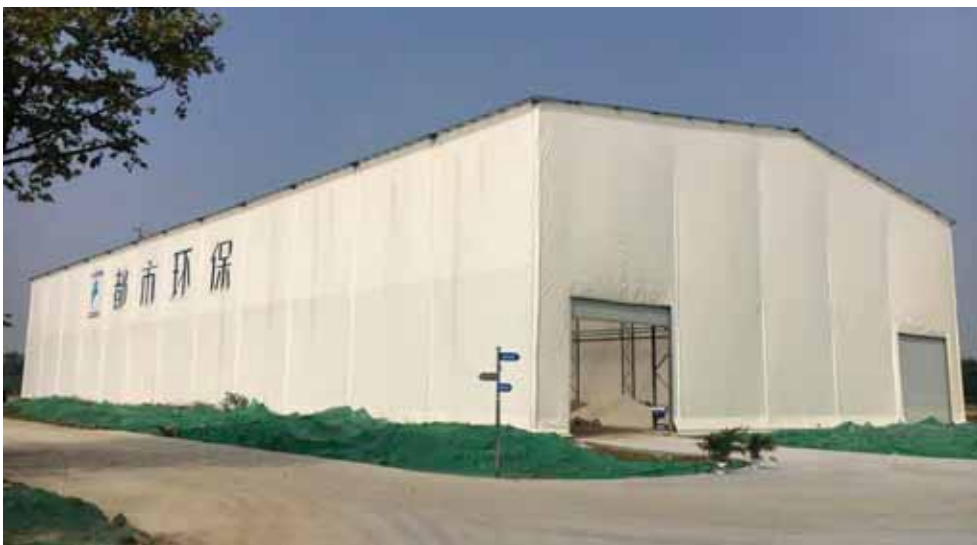
图 6.7 污染土壤修复车间
