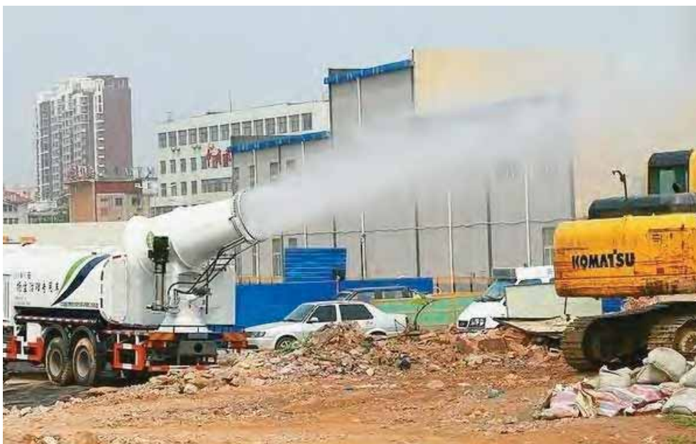
图 7.6 场地平整环节多功能抑尘车降尘
