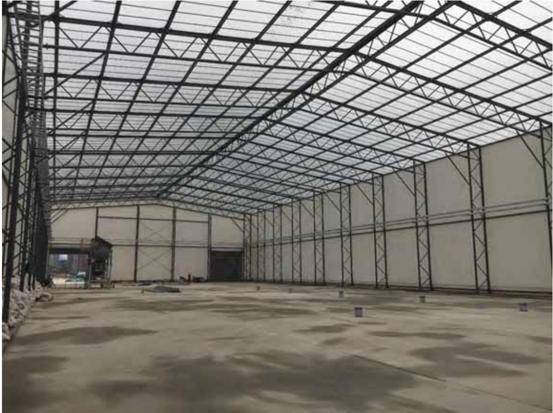
图 7.2 污染土壤修复车间混凝土地坪
