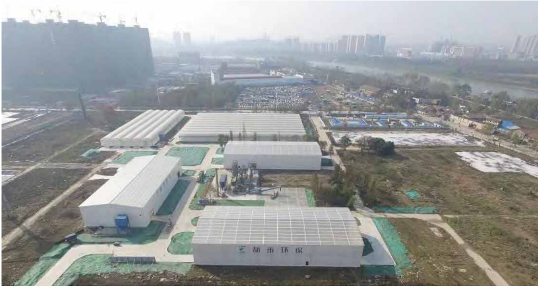
图 6.30 某地块基础设施建设及生态修复项目 EPC 工程总承包项目
