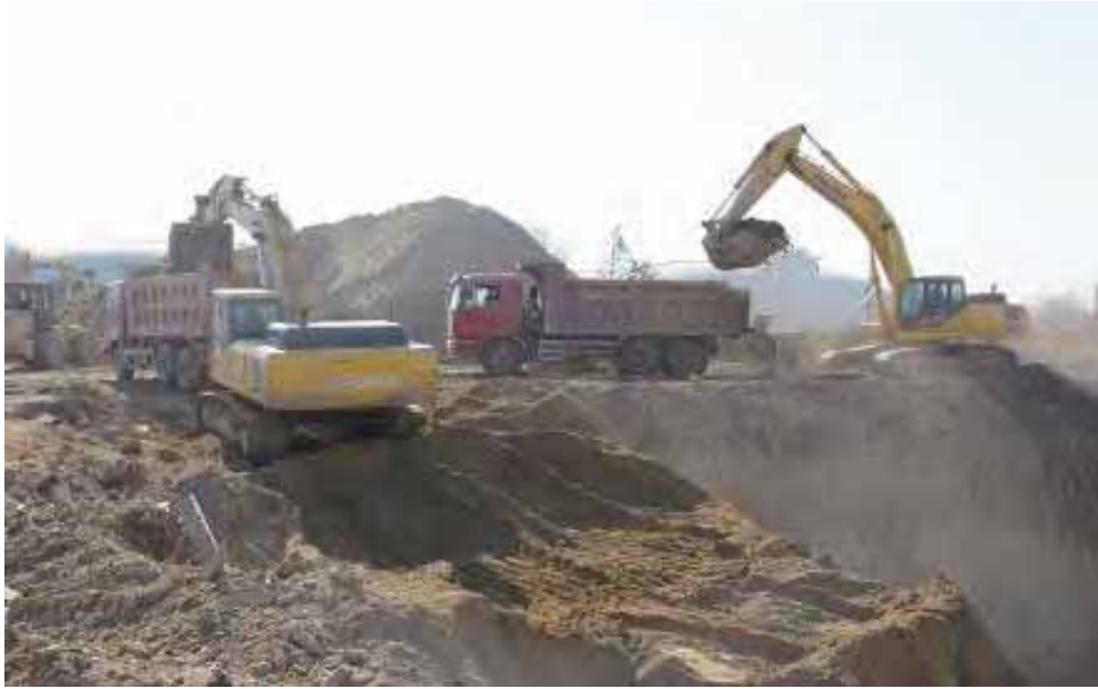
图 8.13 沟端开挖法示意图
