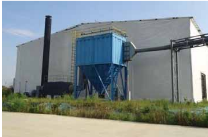
图 7.20 污染土壤修复车间尾气处理装置有组织排放监测点(P1)
